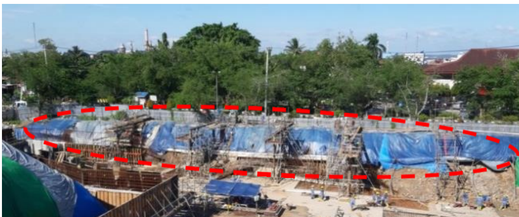
Gambar 2. Tampak Pipa Raw Water (Sumber : Dokumentasi Proyek)
