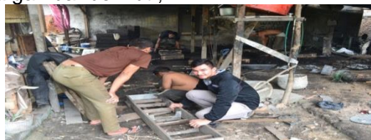
Gambar 7. Pembuatan cetakan kayu
