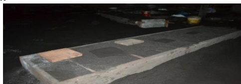
Gambar 9. Cetakan yang siap dituang
