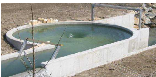
Gambar 2.5 Turbin vortex Zotlöterer
