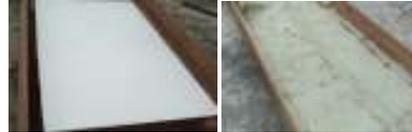
**Gambar: 7 Penentuan pembuatan kotak yang akan di isolasi dengan *rockwool* - Peletakan Kolektor surya**
