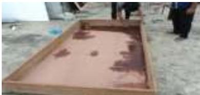
**Gambar: 6 Kotak kayu kolektor - Penentuan pembuatan kotak yang akan di isolasi dengan *rockwool***
