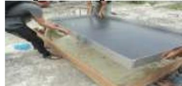
**Gambar: 8 Peletakan kolektor surya - Pembuatan lubang untuk masuk dan keluarnya air di kolektor surya**
