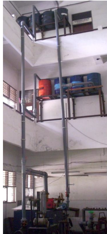
Gambar 3 Foto instalasi pengujian pompa sebagai turbin
