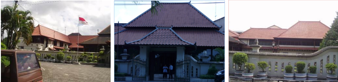
Gambar 7. Kiri : Atap perisai pada gedung Tata Usaha Sonobudoyo. Tengah: gerbang (atap limasan) dan atap limasan bersusun bangunan Pendopo. Kanan: atap limasan dan perisai Bangunan Utama pameran.
