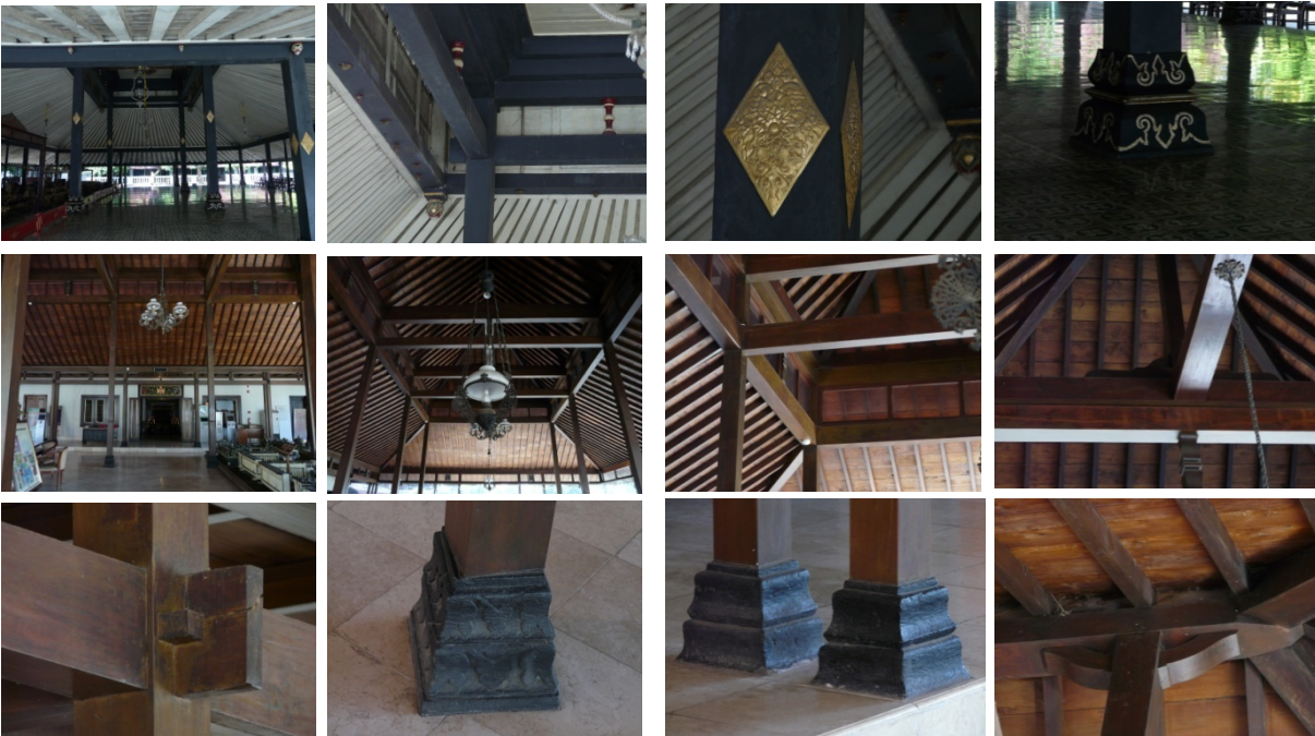
Gambar 9. Baris atas: Struktur rangka Pendopo Kraton Yogyakarta, tiang sokoguru, ring balok atap atas sistem tumpang sari, kolom berornamen, umpak berdekorasi. Baris tengah dan bawah: Struktur rangka Pendopo Sonobudoyo, tanpa sokoguru (tengah 8 tiang), tanpa tumpang sari, kolom polos, umpak sederhana.
