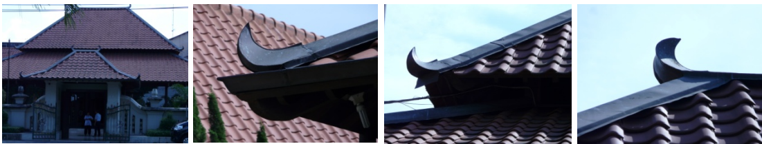
Gambar 18. Wuwung atap Pendopo Sonobudoyo. Kiri: atap gerbang dan Pendopo. Kiri-tengah: ujung wuwung bawah atap Pendopo. Tengah-kanan: Ujung bawah atap atas Pendopo. Kanan: Wuwung atas
