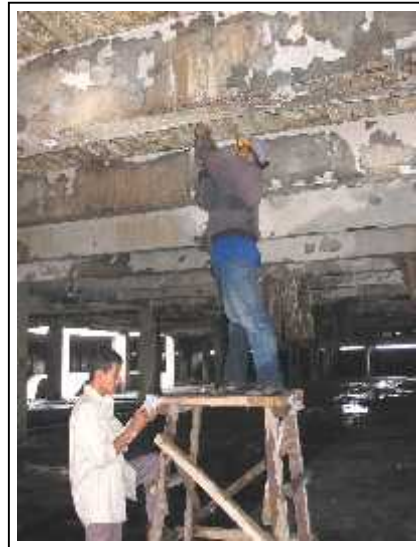
Gambar 2. Hammer Test Pada Elemen Balok Pasar Induk Wonosobo
