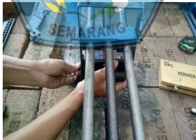
Gambar 8. Pemasangan pulley dan belt
