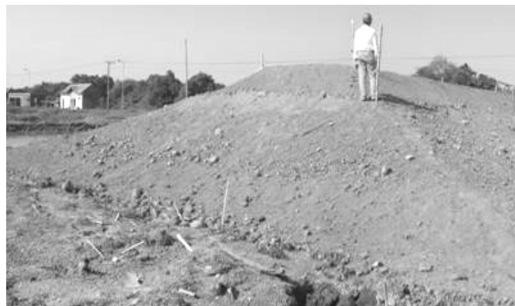
(e) Penyelesaian Timbunan Badan Jalan
