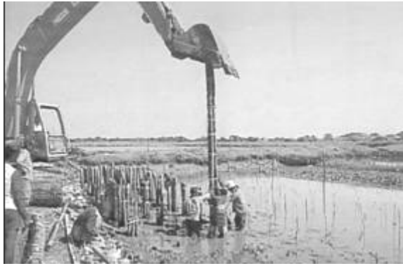
(a) Pemasangan Cerucuk Bambu
