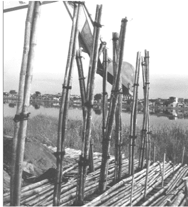
(a) Pemasangan cerucuk bambu
