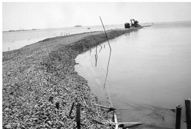
(c) Penimbunan embankment dike di atas cerucuk matras bambu
