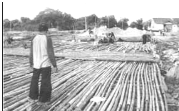
(c) Pemasangan Matras Bambu
