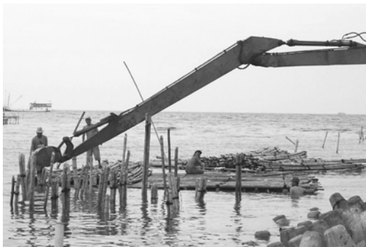
(a) Pemasangan cerucuk bambu
