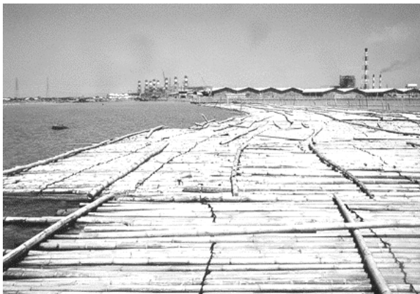
(a) Pemasangan matras bambu
