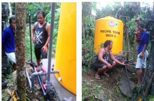
Gambar 3.1. Pemasangan tangki pelepas tekan dan perpipaannya
