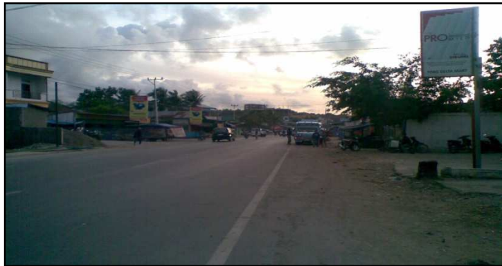
Gambar 5. Segmen Akhir Jalan Timor Raya KM 08+000
