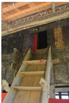
Gambar 19. Eran Banua Layuk Sumber: Dokumentasi Pribadi, 2015
