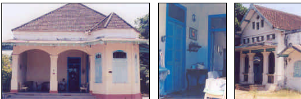
Gambar 5. Tidak terlihat adanya ornamen yang ruwet, tetapi terlihat adanya dekorasi berupa garis geometrik, penyelesaian detilnya lugas, dan ada pintu di samping yang memperlihatkan ciri-ciri tahun 50-an (Dokumentasi penulis, 2004)
