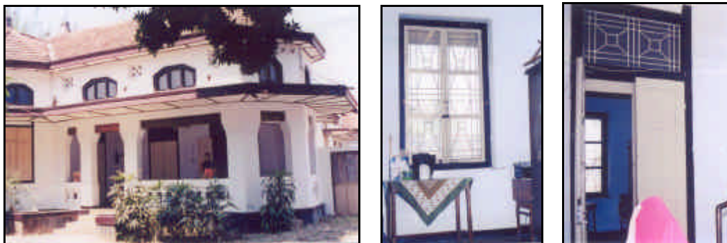
Gambar 4. Atap sudah tidak setangkup, pintu sudah bergeser ke samping, unsur geometris terlihat sangat dominan pada bentuk bangunan, pintu, dan jendela menunjukkan ciri-ciri tipe 50-an (Dokumentasi penulis, 2004).
