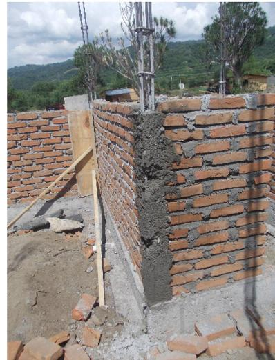
**Gambar 7.** Kesalahan pengecoran pada kolom praktis
