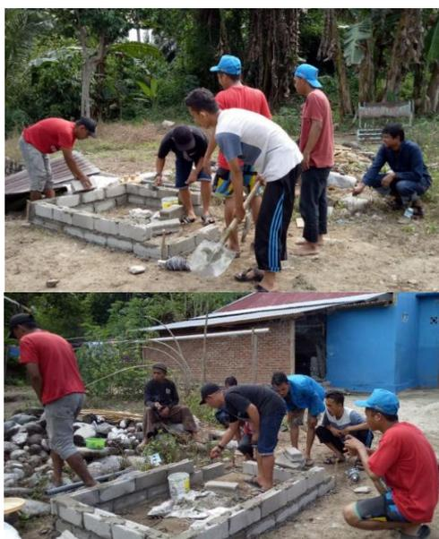
Gambar 10. Pembuatan bak pengomposan permanen
