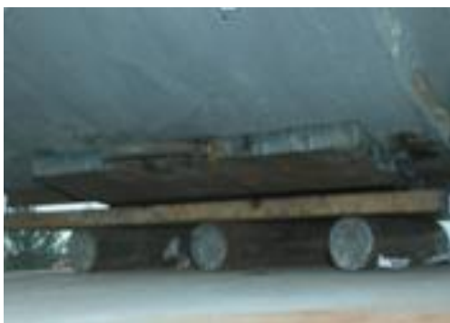
Gambar 5. Cara Pemasangan Alat Rol Geser
