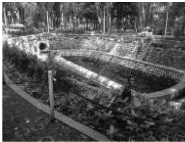
Gambar 5. Kondisi Kolam Resapan Yang Ada Di Hutan Malabar
