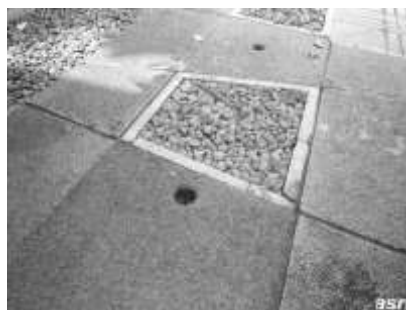
Gambar. 6 Solusi resapan air hujan Sumber: Ujianto, 2018
