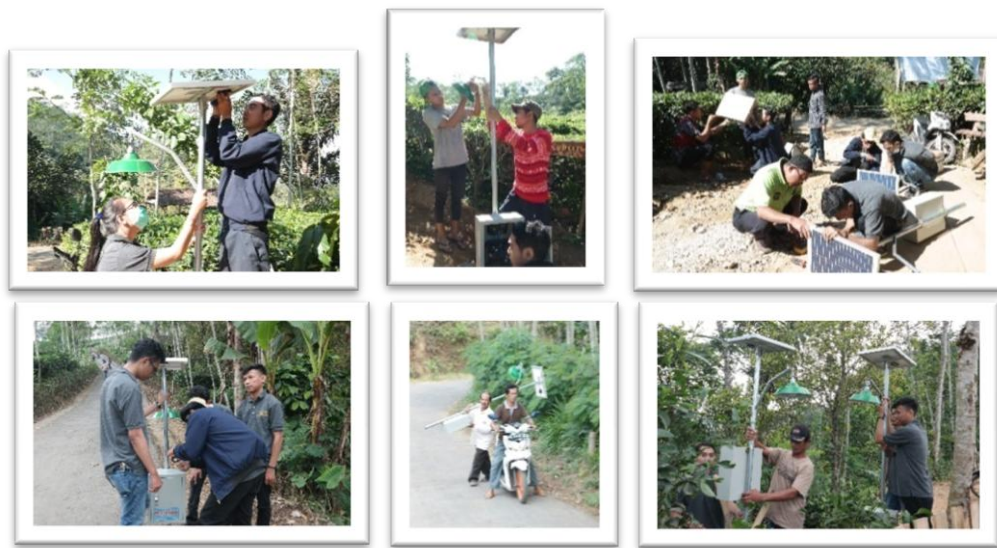
Gambar 11. Proses Pemasangan Alat
