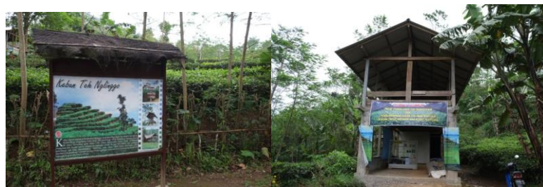
Gambar 2. Lokasi Pemasangan Solar Cell di Dusun Nginggo
