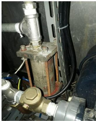
Gambar 17. Hasil penempatan water level control
