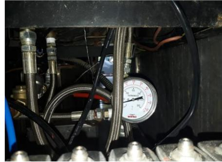
Gambar 13. Pengukuran menggunakan bimetal thermometer
