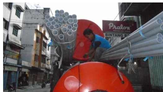
Gambar 7. Pengadaan pipa PVC, sambungan pipa dan tangki air
