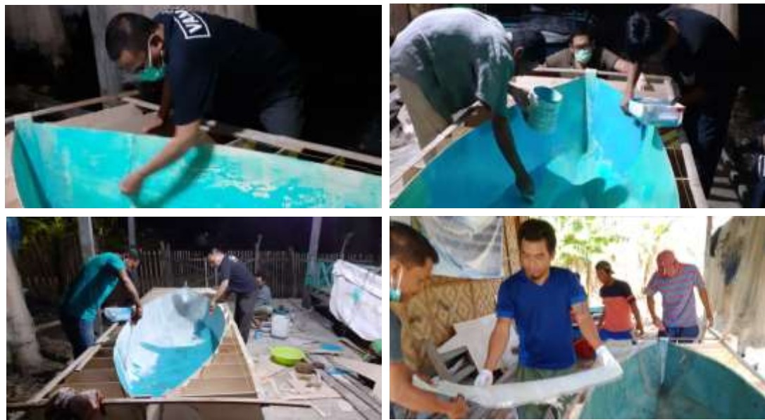
Gambar 10. Proses Laminasi Sumber: Dokumentasi tim (2019)
