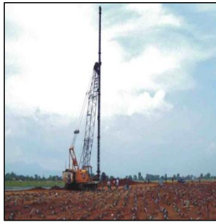
Gambar 13. Alat Pemasangan Geotextile
