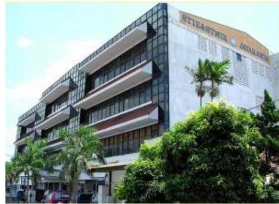
Gambar 4.1 Gedung STMJK Jayakarta
