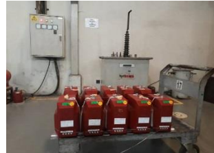
Gambar 10. Pengujian Applied pada Sisi Sekunder
