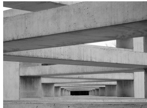
Gambar 3.3 Beton yang sudah dicetak menjadi balok dan kolom
