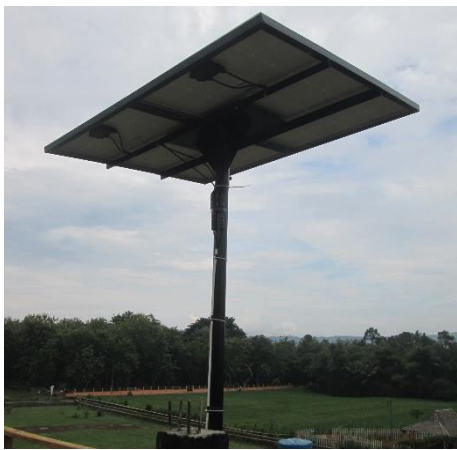
Gambar 2. Posisi pemasangan panel surya
