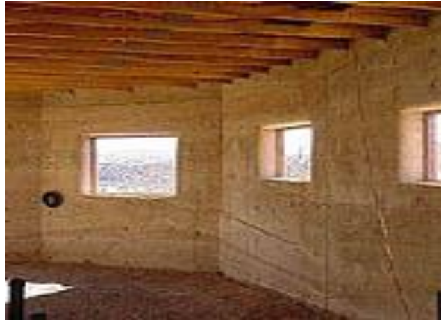
Gambar 8. Pembuatan dinding bangunan rumah berbahan papercrete
