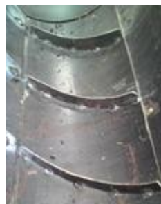
Gambar 9. Penambahan Plat Penahan pada Penutup Atas
