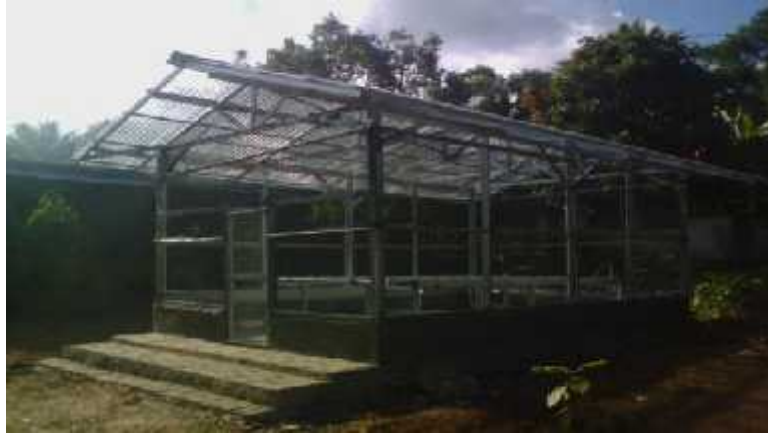
Gambar 3. Pembuatan Green House
