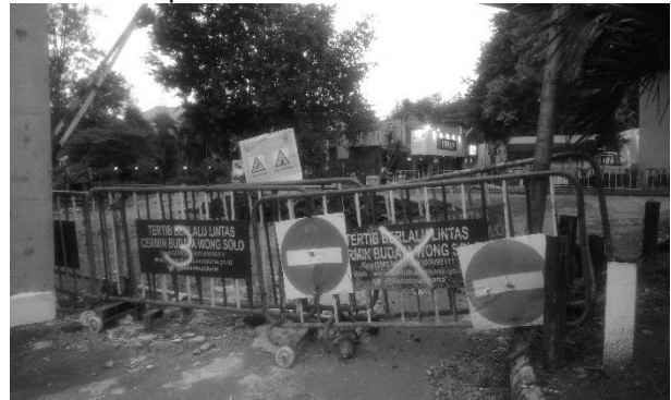
Gambar 6. Penutupan akses pengguna jalan yang akan melewati perlintasan kereta api
