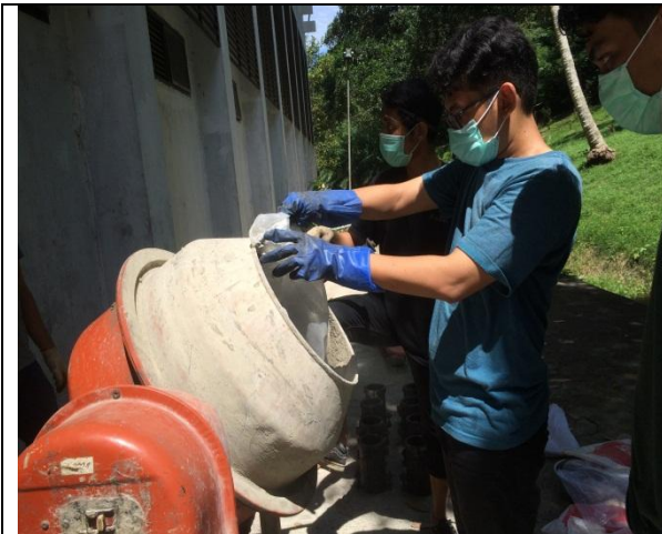
Proses Pengadukan Beton
