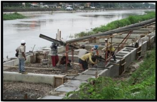
Gambar 5. Pengecoran Copping Pada CCSP
