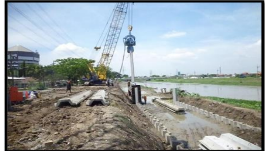
Gambar 3. Proses Driving pile CCSP dengan Vibro Hammer
