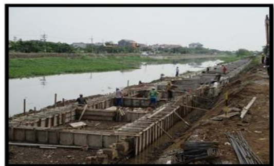
Gambar 4. Pekerjaan Bekisting Pada Coping Beam Diatas CCSP
