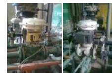
Gambar 4.3 Katup air dan katup udara
