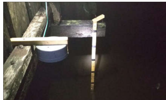
Gambar 34. Dokumentasi Pemasangan Alat
