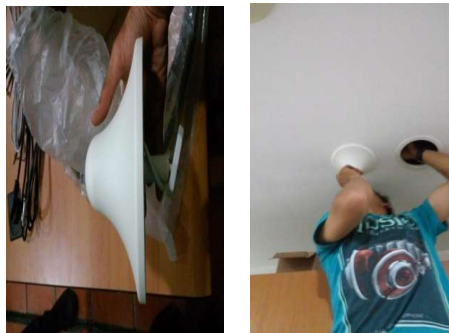
Gambar 22. Antena Omni yang Dipasang
