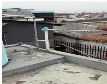
Gambar 19. Antena Donor yang dipasang di spotcheck
