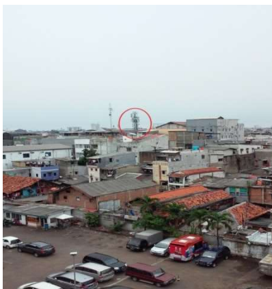
Gambar 17. Foto Tower yang Meng- cover
