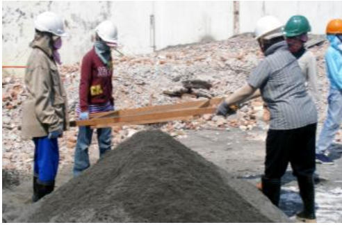
Gambar 2. Proses pengayakan manual dengan dua orang secara bersamaan.
