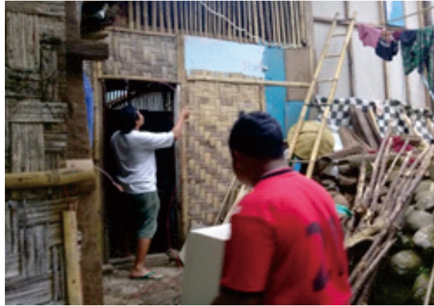
Gambar 12. Pemasangan saluran kabel listrik dari pembangkit listrik tenaga pikohidro ke lokasi rumah Mitra
