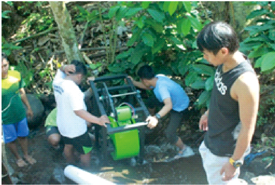
Gambar 9. Proses pemasangan pembangkit listrik tenaga pikohidro di lokasi dekat Mitra (1)
