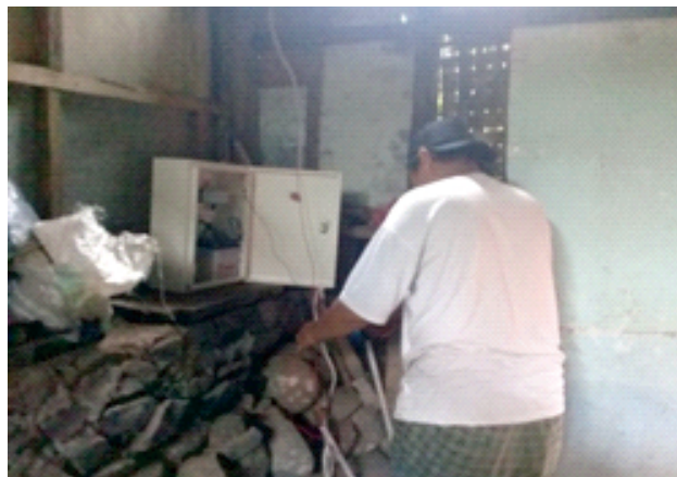
Gambar 13. Pemasangan panel kontrol di dalam rumah Mitra
