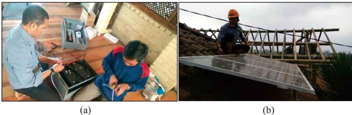
Gambar 3. (a) Pemasangan batrei (b) pemasangan panel surya di lokasi mitra.
