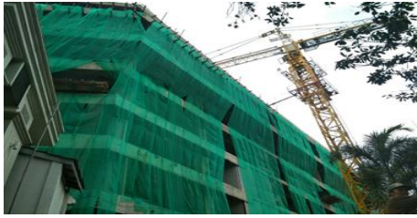
Gambar 4. Pemasangan Jaring-jaring (Safety Nett)
