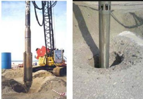
Gambar 4. Pemasangan pada Pasir
