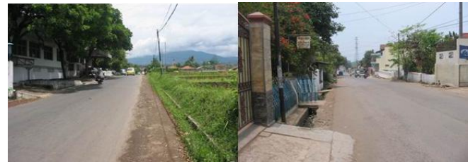
Gambar 3.7 Kondisi pedestrian pada jalan Stasiun/Cihaliwung sebelah barat (Wijaya, 2015)
