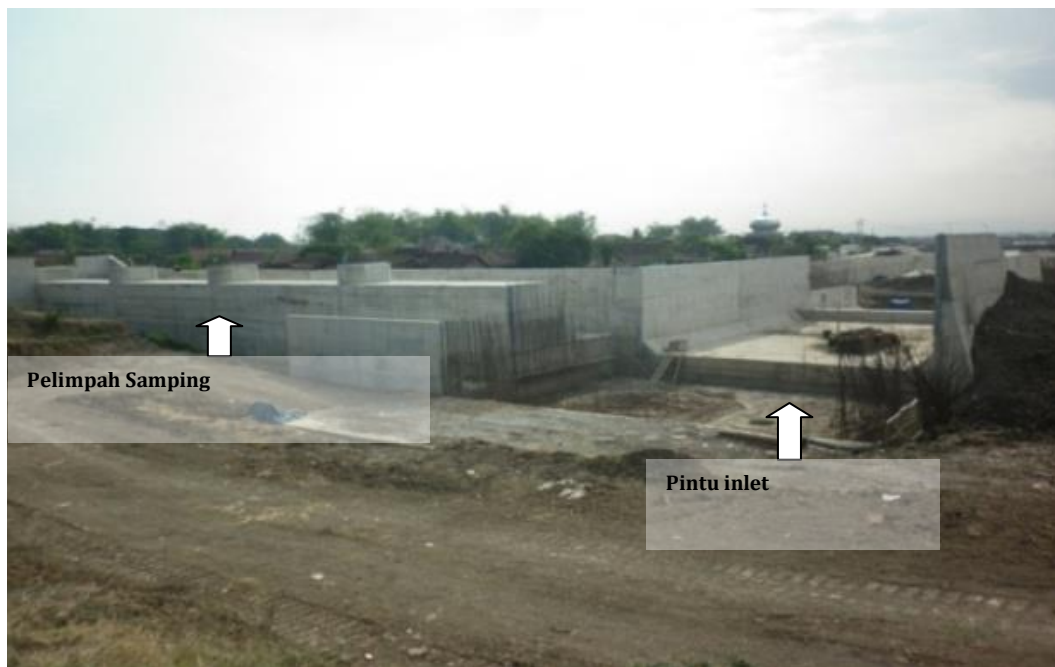
Gambar 18 Pelaksanaan bangunan inlet Rawa Jabung sampai saat sekarang (2013)
