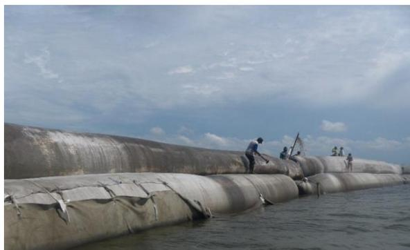
Gambar 7 Tipikal *geotube* (kiri) dan contoh *geotube* di Pantai Pusong, Aceh (kanan) (Sumber : PT. KPAM)
