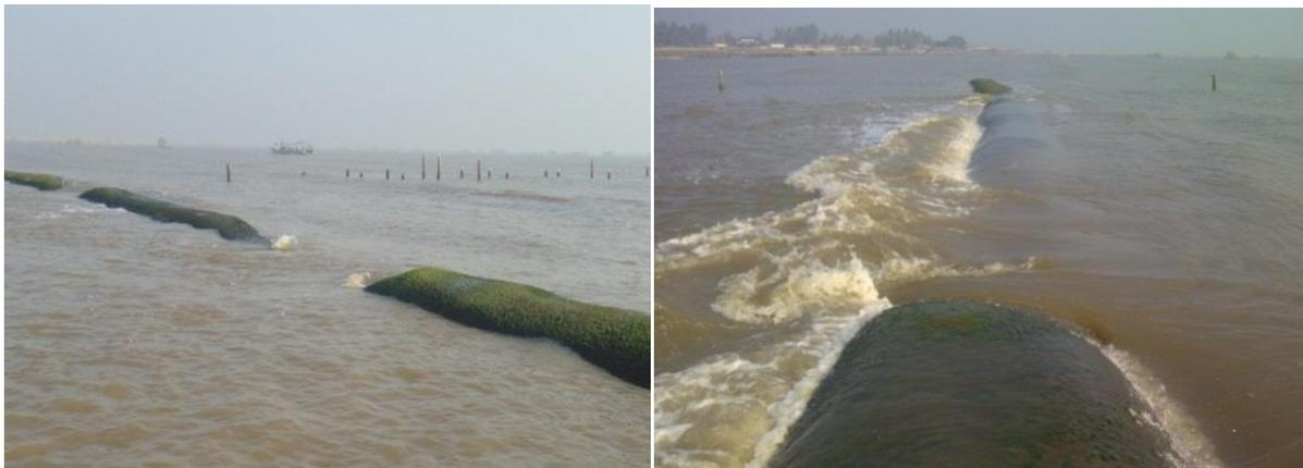
Gambar 12 Kondisi PEGAR Geotube Tanjung Kait dan gelombang pecah saat melewati geotube
