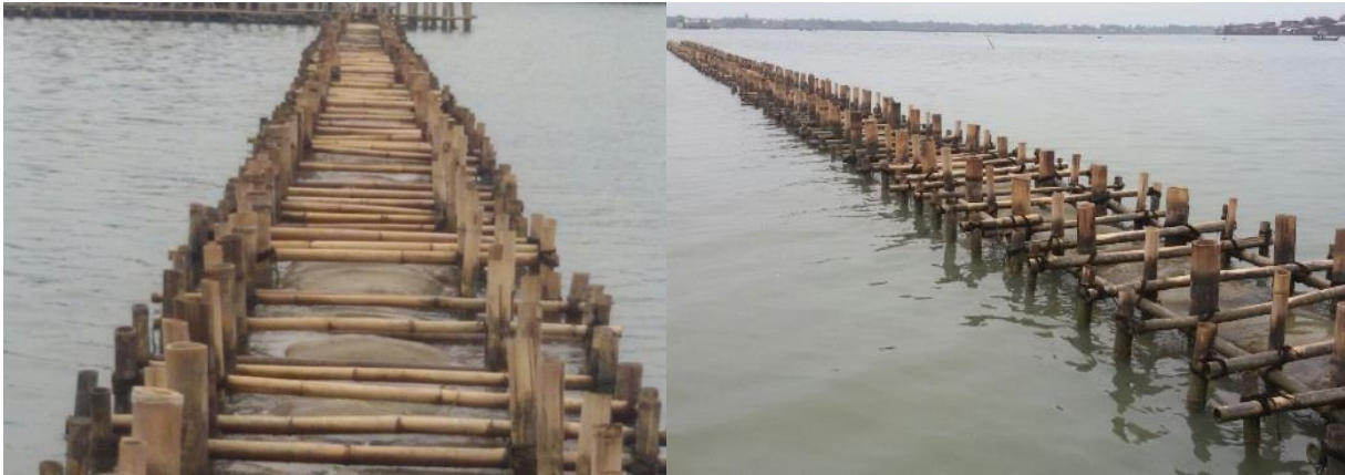
Gambar 13 Prototipe PEGAR geobag rangka bambu di Pantai Sriwulan, Demak (Pusair, 2016)
