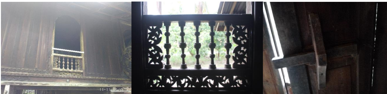
Gambar 12. Jendela (kiri), Hiasang Gasing (tengah) dan Pengkelang /pengunci jendela (kanan) Sumber: Dokumentasi Pribadi, 2018
