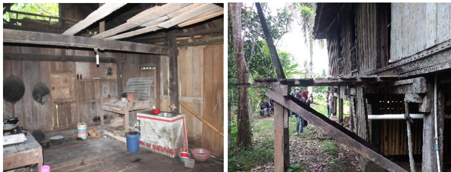
Gambar 8. Pandapuan / dapur (kiri) dan pelantau / pelantaran (kanan) Sumber: Dokumentasi Pribadi, 2018
