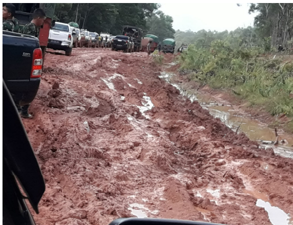
Gambar 1. Kondisi jalan yang menghubungkan Merauke dengan Boven Digoel
